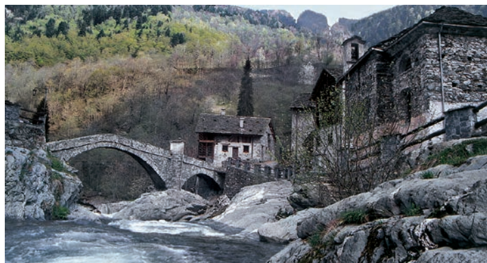
RASSA - PONTE IN PIETRA
