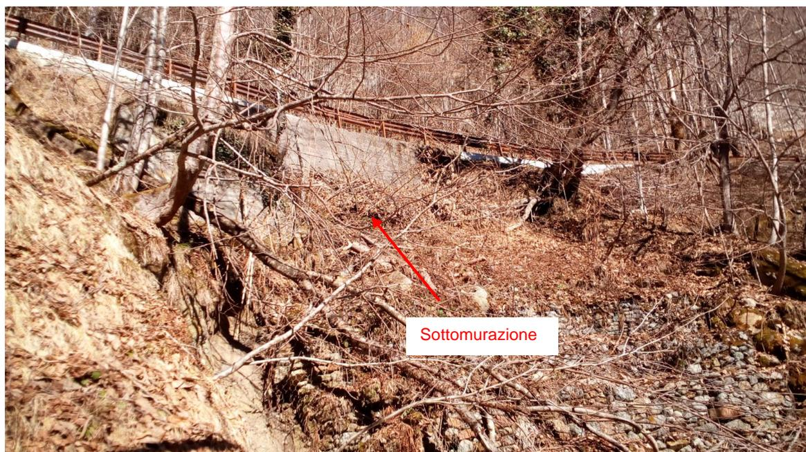
Figura 27 – Vista del muro esistente, oggetto di intervento vista da valle della strada con la segnalazione degli interventi previsti
